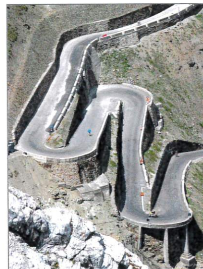
Serpentinvägar är ett bra exempel på lutande plan . Man får köra en längre sträcka, men samtidigt blir det inte en särskilt brant vägbana.
