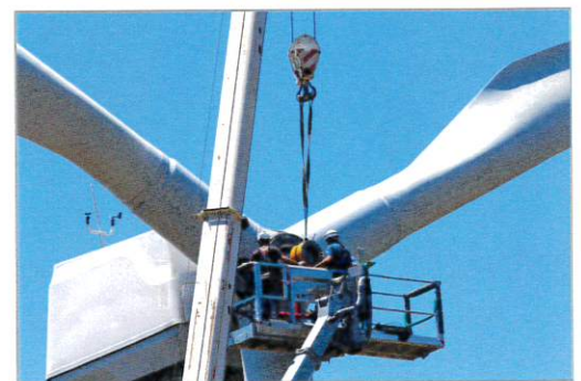
Rotorbladen på ett vindkraftverk repareras.
