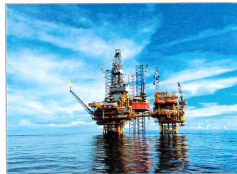
För att få upp oljan och gas borrar man djupt ner i havsbotten från stora oljeplattformar .
