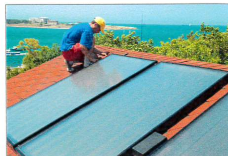
Solfångare monteras på hustak.
