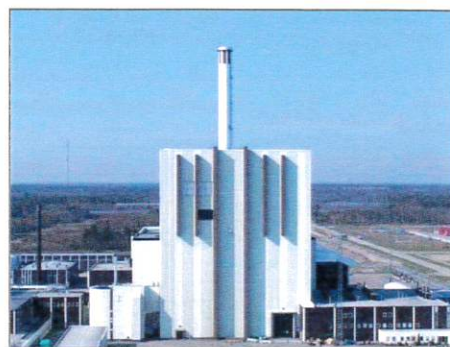
Reaktor 2 vid Forsmarks kärnkraftverk
